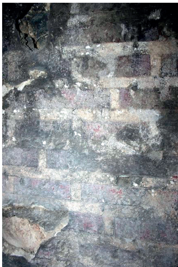
Fig. 21: Detalle del falso despiece del tímpano.
